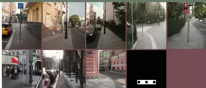
Улица Пречистенка, Земледельческий и Неопалимовский переулки. Капитальный ремонт 2022 г.
