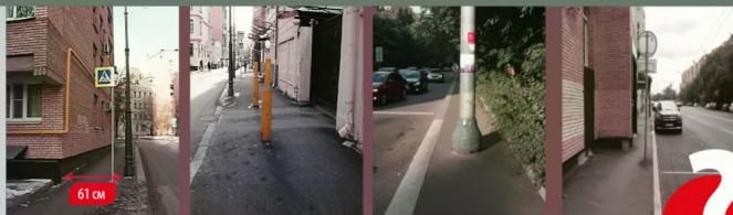
Москва. Земледельческий и Неопалимовский переулки. Капитальный ремонт 2022 г.
