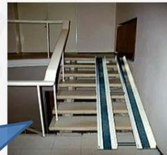
3.1 **аппарель:** Элемент обустройства пешеходного пути в виде монолитной или накладной конструкции, в том числе на лестничном марше или через препятствие, состоящий из двух отдельных направляющих для перемещения средств на колесах и прохода между ними.
