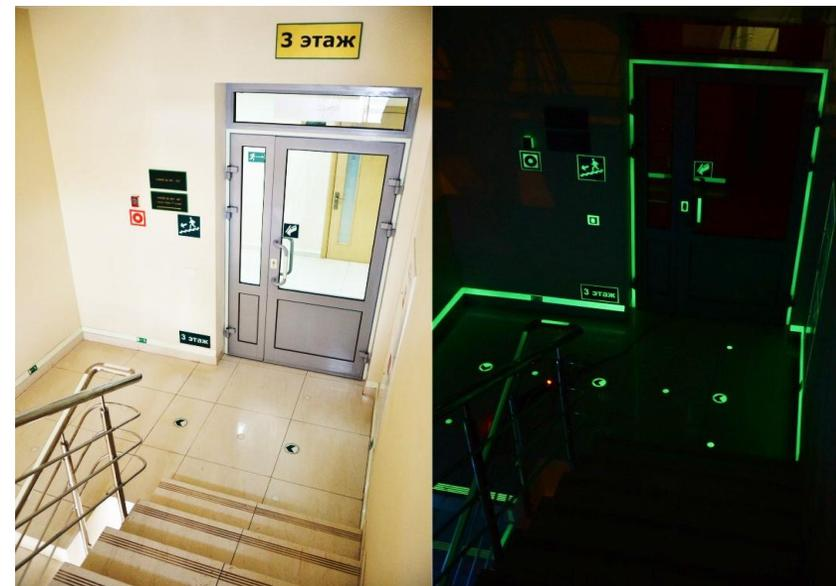
СП 1.13130.2020 Дверные проемы, предусмотренные на путях эвакуации МГН, относящихся к группе мобильности М4, **не должны иметь порогов высотой более 1,4 см.**
